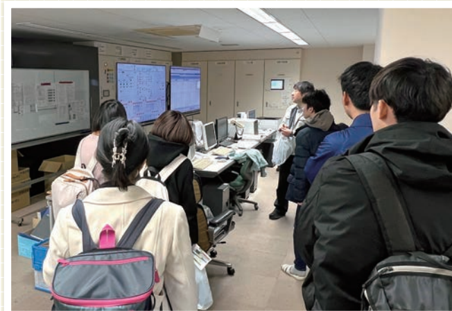
エネルギーセンターの心臓部、中央監視装置です
