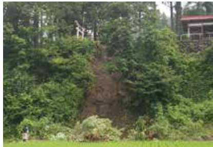
平成26年大雨による土砂崩れ
